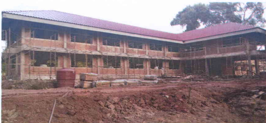
นายสมศักดิ์ จันทรมบัติ ผตปค.เขต ๑๑,๑๓ ตรวจสอบและติดตามการก่อสร้างอาคารที่ว่าการอำเภอ หลังใหม่ อ.บุญศรี จ.อุบลราชธานี
